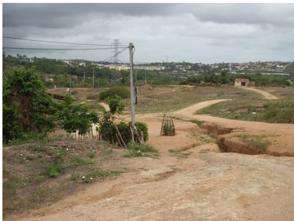
Figura 4 - Ravina próxima a uma residência
