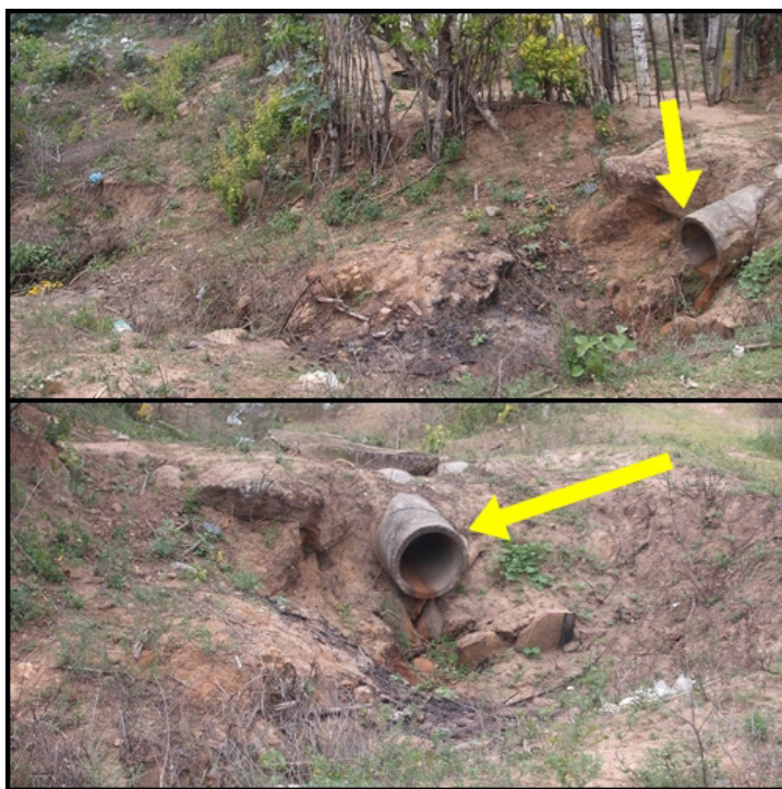
Figura 10 A e B - Lançamento de águas servidas diretamente no solo, potencializando a erosão linear e encharcamento do solo
