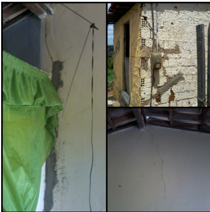
Figura 7 A, B e C - Rachaduras na estrutura das casas
