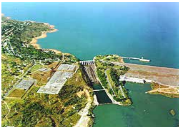
Figura 9: Barragem Três Marias (CEMIG).
