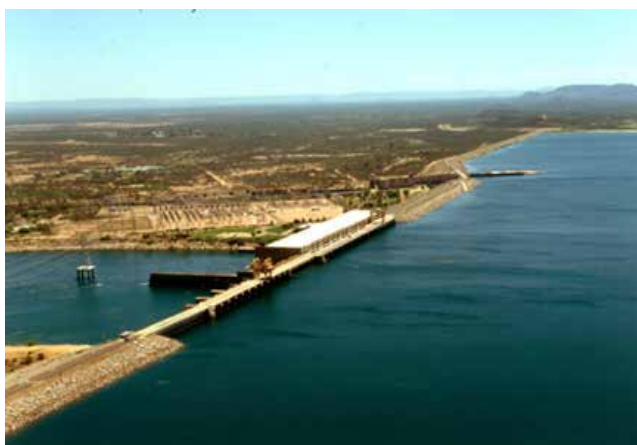
Figura 10: Barragem Sobradinho (CHESF).
