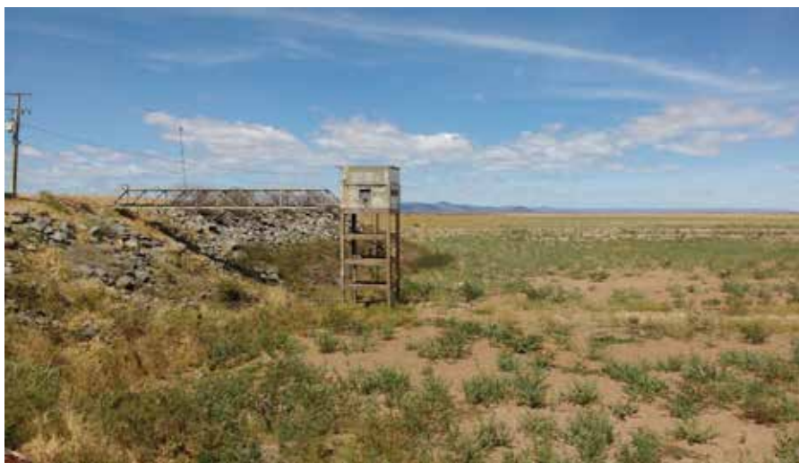
Figura2: Vista do sistema de captação da Nova Remanso desativado. (Edcarlos Mendes, julho de 2017).
