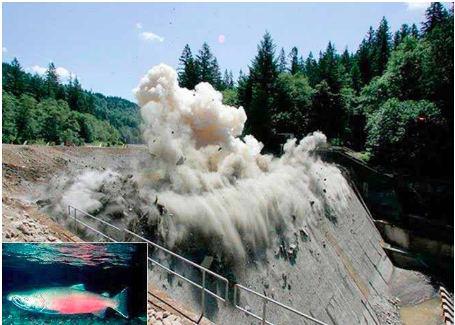
Figura 1: Explosão da Barragem de Elwha Dam (EUA)
