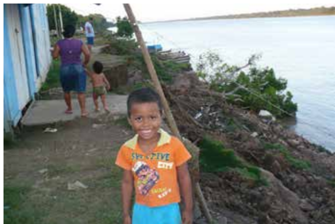
Figura 8: Desbarrancamentos em São Carlos. Rondônia, 2011. Acervo: PNCSA/UEA.
