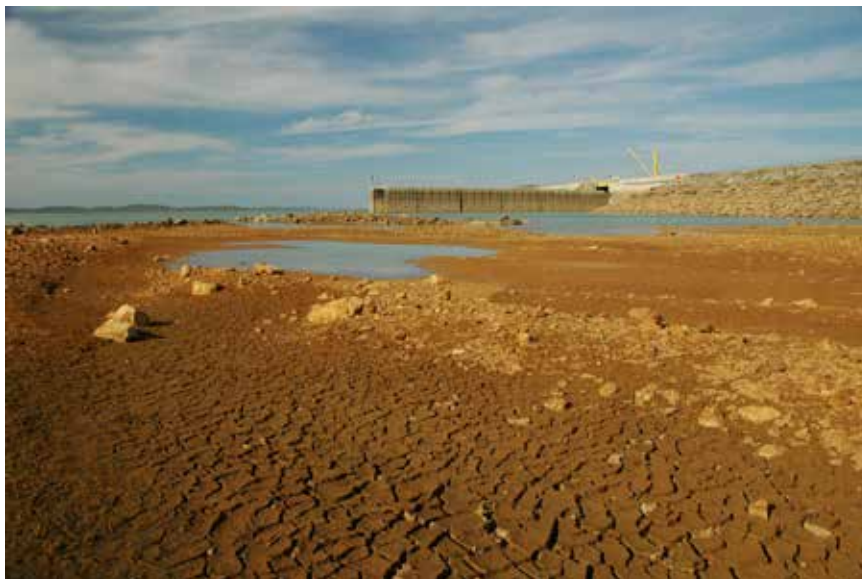
Figura3: Barragem de Sobradinho (ZINCLAR, 2010)
