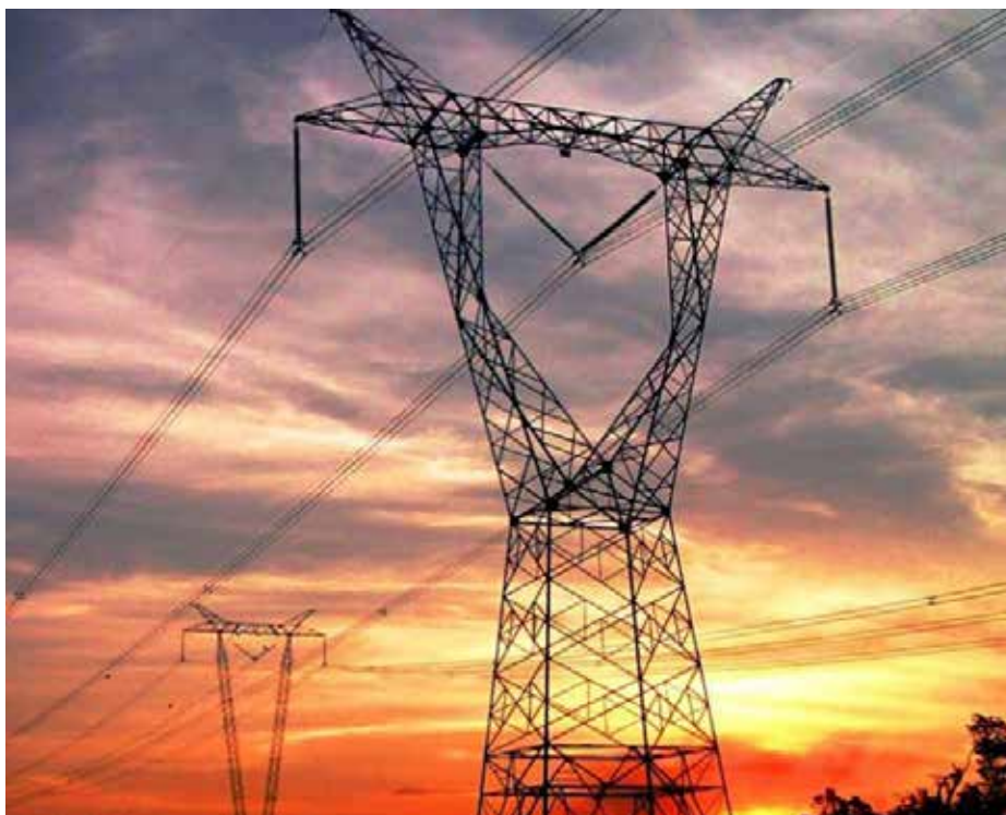
Figura 1: Torre de alta tensão (Bocão News)
